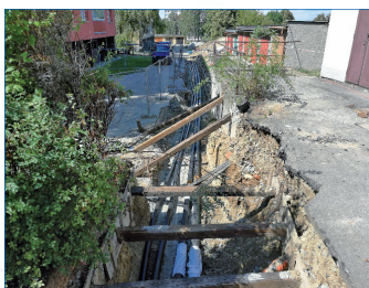
Rekonstrukce venkovních rozvodů ul. Kabelíkova 3 a 5
