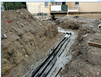
Rekonstrukce venkovních rozvodů ul. U Tenisu 8-14
