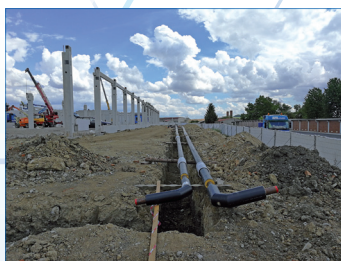
Rekonstrukce venkovních rozvodů – napojení nákupní galerie
