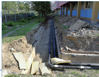
Rekonstrukce venkovních rozvodů v Předmostí (ZŠ J.A. Komenského)
