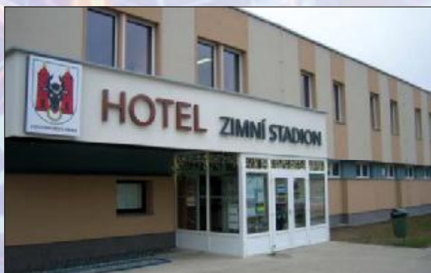
Zateplení hotelu Zimní stadion
