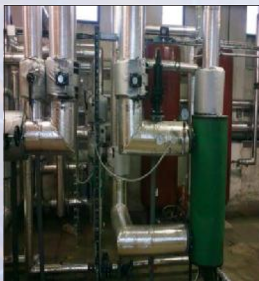
VST Kabelíkova – rekonstrukce technologie výměníkové stanice
