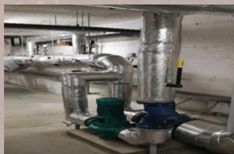
Instalace nového čerpadla ÚT ve VST Slaměnikova 5
