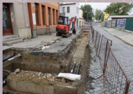
Horkovodní přípojka pro novou radnici, ul. Jateční, Přerov
